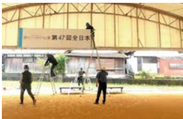
看板設置作業の様子
