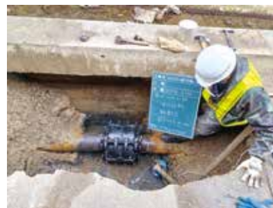
組合による地震復旧活動の様子
