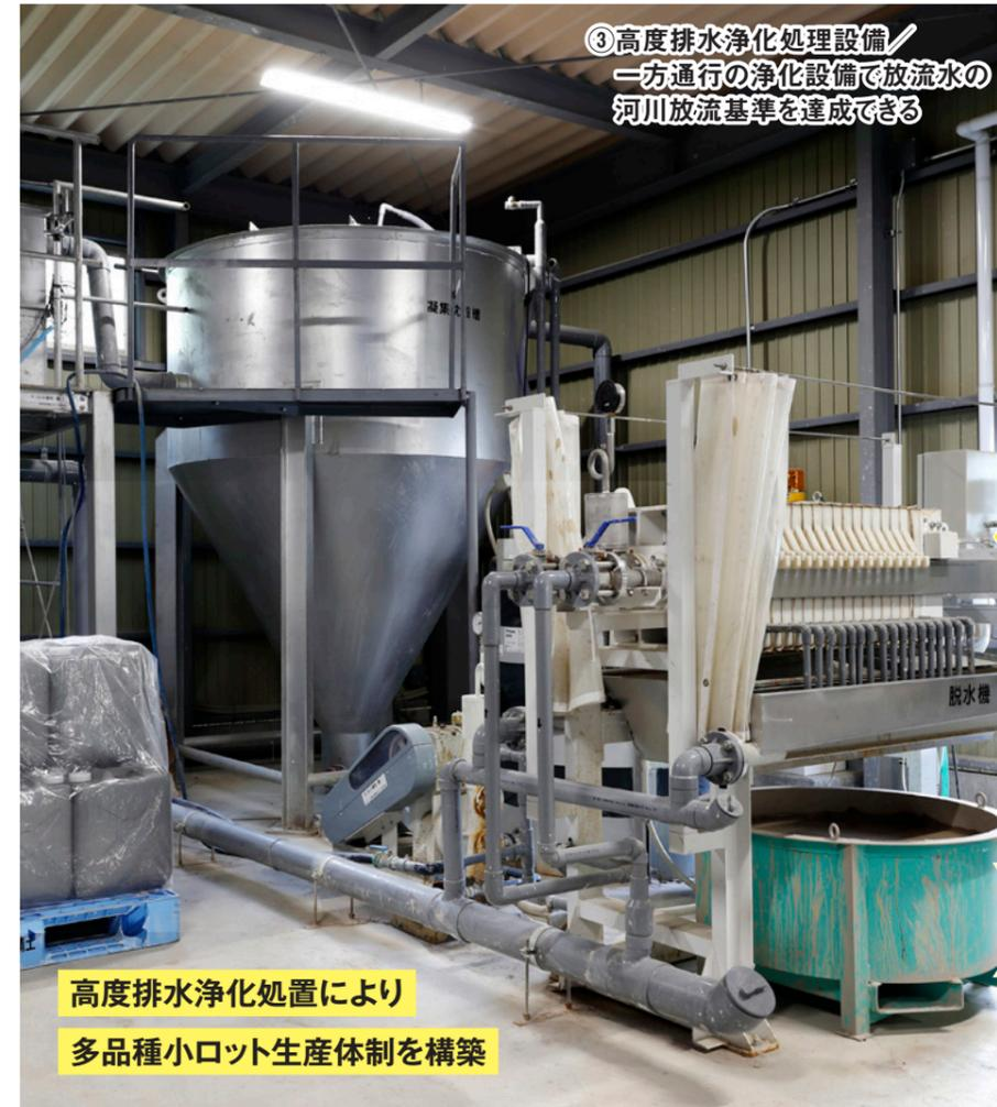
③高度排水浄化処理設備 / 一方通行の浄化設備で放流水の河川放流基準を達成できる
