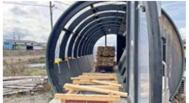
太陽熱利用パッシブ木材乾燥庫
