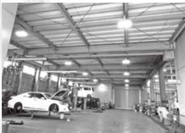
高効率化された工場の照明
