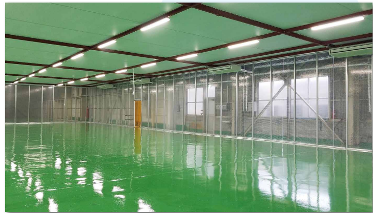
膜天井及び透明間仕切り壁
