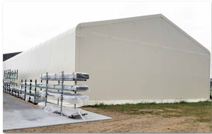
大型テント構造物
