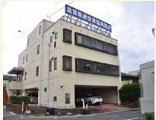
滋賀県遊技業協同組合 事務所
