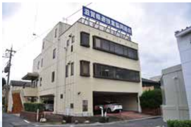
滋賀県遊技業協同組合 事務所
