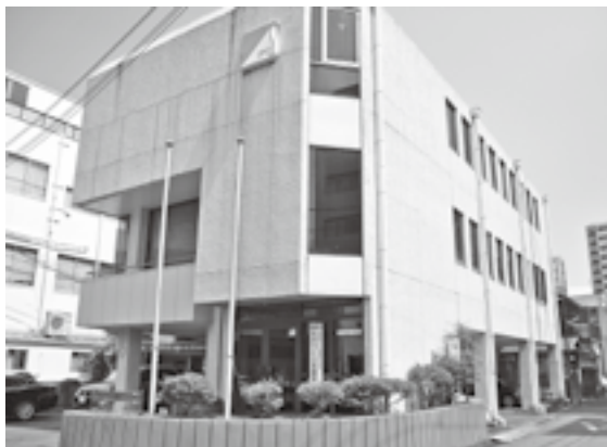
ものづくり支援室建物外観
